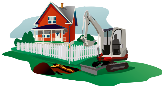
Bild 33 - Vid arbete bör man kontakta elnätsföretaget i god tid innan arbetet påbörjas för kostnadsfri utsättning av kablar.
